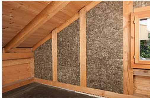
Panneau isolant universel pour les constructions à ossature bois et les murs à double paroi.
