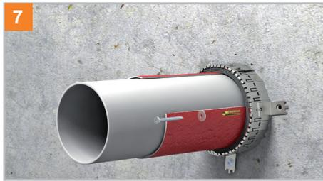
Jeden Befestigungspunkt mit entsprechend zugelassenen Dübeln an der Wand / unter der Decke befestigen. Bei leichten Trennwänden oder Mineralfaserabschottungen mit Gewindestangen M6 oder M8 arbeiten. Abschließend muss die Abschottung dauerhaft mit einem Kennzeichnungsschild deklariert werden.
