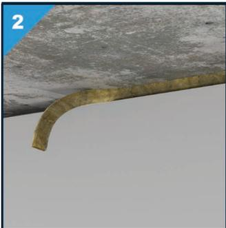
Wenn ein Hinterfüllmaterial verwendet wird, schneiden Sie es etwas breiter als die Fuge und vergewissern Sie sich, dass es in der richtigen Tiefe in der Fuge angebracht wird.
