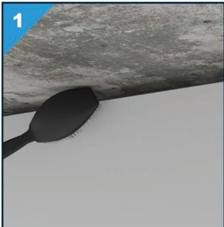
Stellen Sie sicher, dass die Fuge frei von Staub, Schmutz und Fett ist. Befeuchten Sie die Konstruktion.
