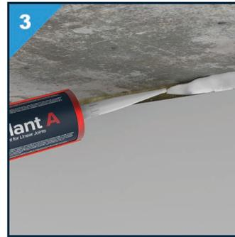
Appliquez généreusement le mastic Multisealant A dans le joint pour éviter les bulles d'air.
