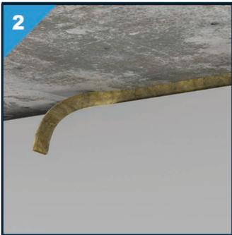
Si un matériau de soutien est utilisé, coupez-le légèrement plus large que la largeur du joint et assurez-vous qu'il est appliqué à la bonne profondeur dans le joint.
