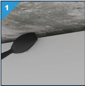
S'assurer que le joint est exempt de poussière, de saleté et de graisse. Humidifiez la construction.
