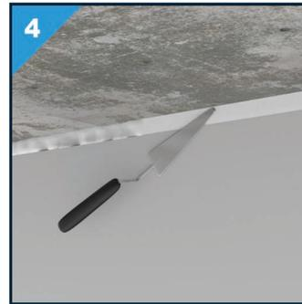
Lissez le joint à l'aide d'une spatule humide ou d'un couteau à mastic.
