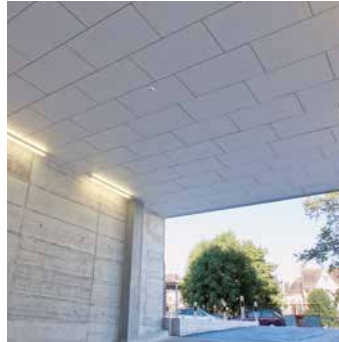
Beispiel einer Tiefgarageneinfahrt.
