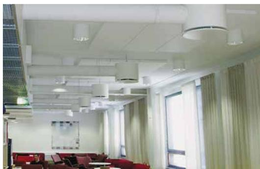
Panneau isolant homogène avec surface apparente en voile de verre blanc. Bords intégralement chanfreinés et revêtus de blanc couvrant. Pour les plafonds de caves, de halles et de garages souterrains ainsi que pour les pièces intérieures exigeant une bonne isolation acoustique.
