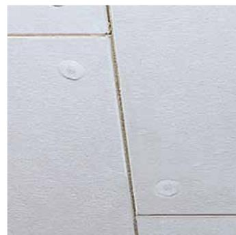
Montage avec tampons spéciaux et perceuse.
