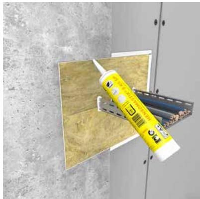
Tragen Sie eine dicke Schicht **HENSOMASTIK® 5 KS Farbe / viskos** auf alle Schnittflächen und Außenkanten der Mineralfaserplatte auf.
