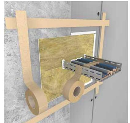
Kleben Sie den Rand für eine mindestens 20 mm breite umlaufende Beschichtung mit Klebeband ab.
