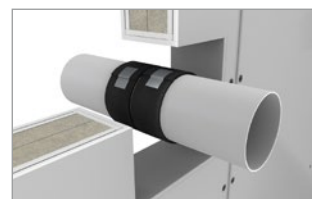
Fertige Wicklung mit Gewebeband fixieren
