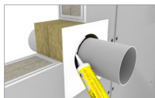
Afdichten sparing rondom met HENSOMASTIK® 5 KS SP
