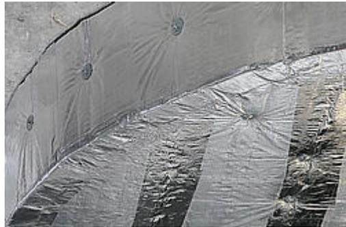
Kompakte Dämmplatte mit einseitiger Alubeschichtung für die Wärme- und Schalldämmung von Lüftungskanälen.
