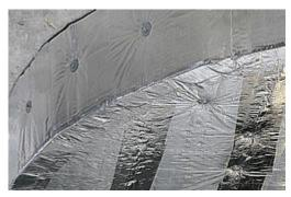
Panneau isolant compact avec revêtement alu sur une face pour l'isolation thermique et phonique de canaux de ventilation.
