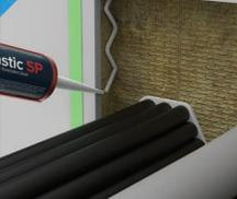
Kleben Sie die Multimastic-FB Brandschutzplatte mit Multimastic-SP-Spachtelmasse in die Konstruktion und verleimen Sie es mit den Durchführungen.
