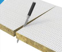
Sägen oder schneiden Sie die Multimastic-FB Brandschutzplatte auf die gewünschte Größe.
