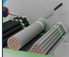
Les joints et les ouvertures autour des pénétrations et de la structure, avec Multimastic SP pâte de remplissage et lisser le joint avec une spatule humide ou un couteau à mastic.
