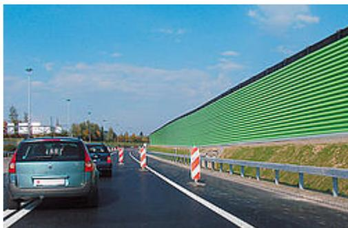
Panneau isolant homogène pour parois anti-bruit et pour l'absorption phonique.
