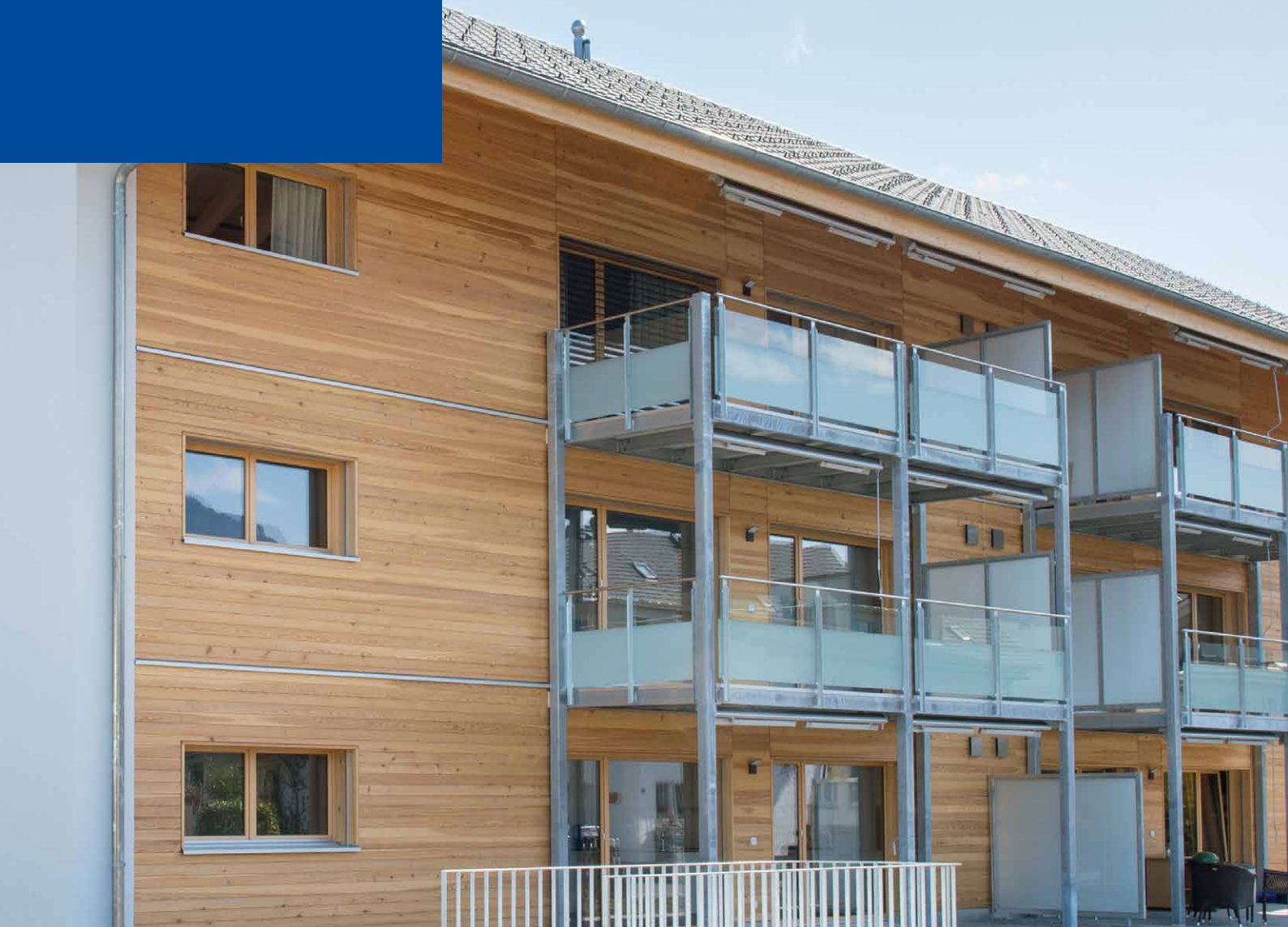
Projekt: MFH Schulstrasse 51, 3604 Thun, BE
