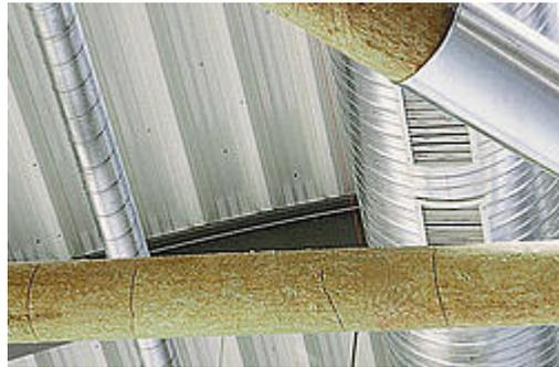
Druckfeste, formstabile Rohrschale. Brandschutzbekleidung von runden Stahlstützen und Windverbänden für die Feuerwiderstandsdauer von 30 – 120 min. Bekleidung von Feuerlöschleitungen bis 90 min.
