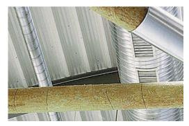
Coquille stable de forme et résistante à la pression. Revêtement anti-feu de piliers ronds en acier et contreventements pour une durée de résistance au feu de 30 — 120 minutes. Revêtement de conduits d'extincteurs jusqu'à 90 min.
