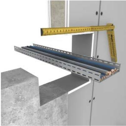
Mesurez la longueur et la largeur de l'ouverture et des conduites d'alimentation pénétrantes et reportez les dimensions sur les panneaux de fibres minérales.
