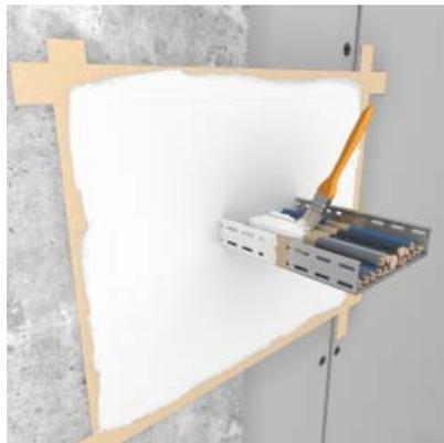
Appliquez **HENSOMASTIK® 5 KS Farbe / viskos** sur les câbles et les structures de support de câbles (épaisseur de la couche sèche  $\geq 1$  mm).
