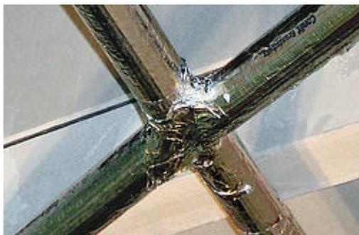
Druckfeste, formstabile Rohrschale mit Alubeschichtung. Brandschutzbekleidung von runden Stahlstützen und Windverbänden für die Feuerwiderstandsdauer von 30 – 120 min. Bekleidung von Feuerlöschleitungen bis 90 min.
