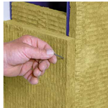
Fixieren der Brandschutzbekleidung mit Metallstiften bis der Kleber ausgetrocknet ist (bis zu 12 Stunden).
