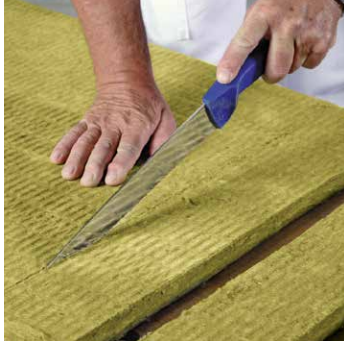
Zuschneiden der Platten
