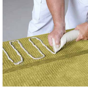
Aufbringen des Conlit® Fix auf die Bekleidung (raupenförmiger Auftrag)
