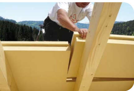
Pose directement sur le chevron
