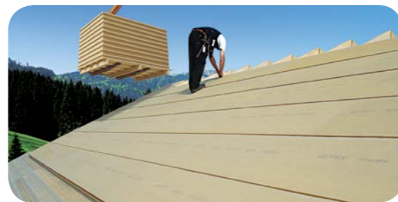
Sous-couverture résistant aux intempéries pendant 12 semaines en tant que toiture provisoire
