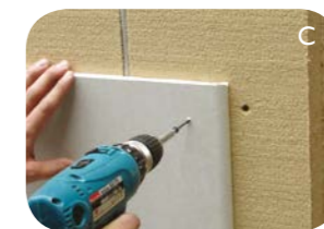
A Fixation de GUTEX Thermostat® B Fraisage des passages de conduites C Pose du panneau en plâtre
