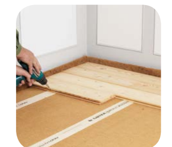
GUTEX Thermosafe-nf® avec baguette de pose sur plancher massif
