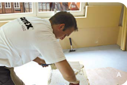
A Appliquer l'enduit adhésif décoratif GUTEX Klebe- und Spachtelputz B Presser fermement GUTEX Thermoroom® C Application de l'enduit intérieur
