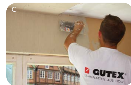
A Appliquer l'enduit adhésif décoratif GUTEX Klebe- und Spachtelputz B Presser fermement GUTEX Thermoroom® C Application de l'enduit intérieur
