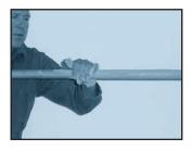
Etalement de la masse DENSO KW comme pâte anticorrosive à enduire. Peut être appliquée simplement à la main.
