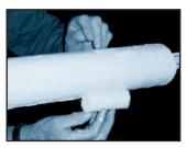
Si le plastique liquide Densital doit être appliqué en plusieurs couches, il faut insérer entre les couches un bandage en coton.
