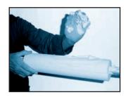
Application du plastique liquide Densital à la main comme écran pare-vapeur. Plus aucune tâche de recouvrement n'est requise.
