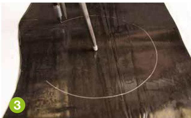
Die Endkappenscheibe mit dem Radius des isolierten Rohrs plus zusätzlich 20 mm ausschneiden.
