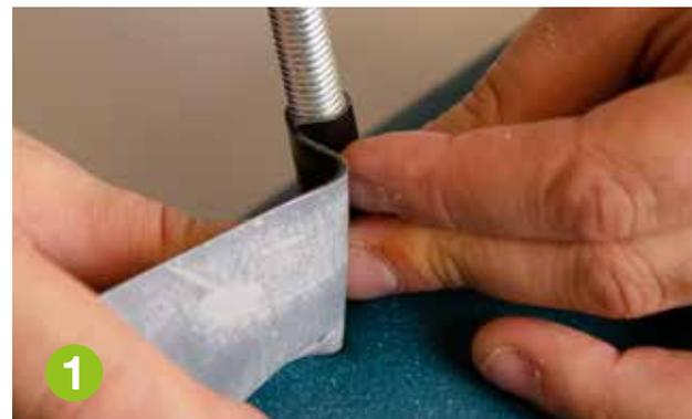
1 Ein kleines Stück Arma-Chek Wrap mit einer Länge von 30-50 mm um die Gewindestange der direkten Halterung kleben.
