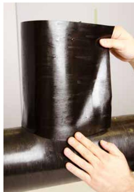
Arma-Chek Wrap mit einer Überlappung von 20 mm auf den Körper auftragen.
