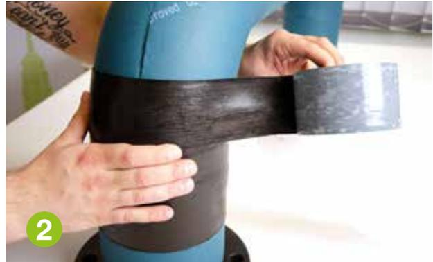
Das selbstverschweißende Abdeckmaterial um das isolierte Rohr wickeln und darauf achten, dass jede neue Lage die vorherige um mindestens 20 mm überlappt.
