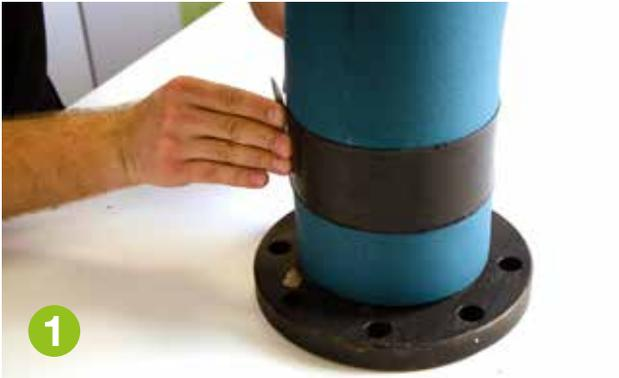
Wenn der Durchmesser der Biegung  $> 90$  mm ist, kann die Wickelmethode angewendet werden. Arma-Chek Wrap in 70 mm Breite verwenden und den Wickelvorgang am unteren Ende des Bogens beginnen und zum anderen Ende vorarbeiten.
