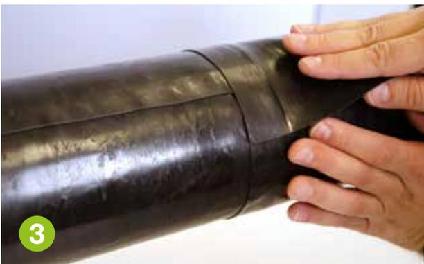
Längsüberlappungen immer versetzt und seitlich mit den Nähten nach unten anlegen, um ein späteres Eindringen von Wasser zu verhindern.
