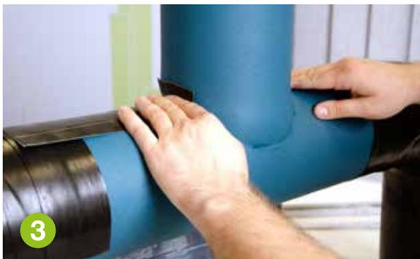
Arma-Chek Wrap positionieren und auf der Dämmstoffoberfläche befestigen.
