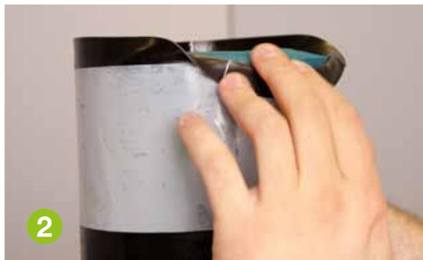
20mm Längszusatz zurückfalten. Um ein Verkleben des gefalteten Bereichs zu verhindern, ist es unerlässlich, ein Trennpapier zwischen dem gefalteten Bereich und der Arma-Chek Wrap Produktoberfläche anzubringen.
