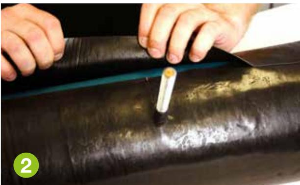
2 Wie bei einer geraden Rohrverkleidung vorgehen. Einen Ausschnitt mit dem Durchmesser der Stange anbringen.
