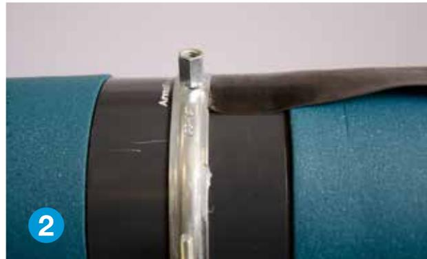
2 Arma-Chek Wrap auf die Oberfläche der ArmaFlex Dämmung und auf die ArmaFix Rohrschellen auftragen.
