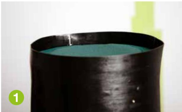
Gerade Rohrisolierung wie oben beschrieben bis zum Ende des Rohrs anbringen. Eine weitere Überlappung 20 mm hinzufügen.
