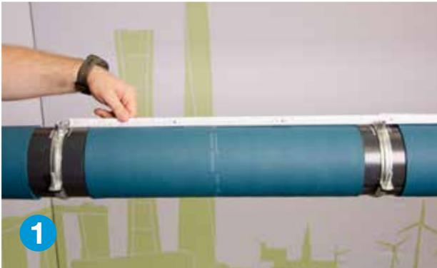
1 Die Länge des geraden Rohres zwischen den beiden ArmaFix Metallschellen messen..
