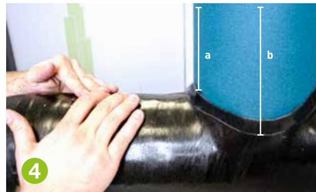
Gleichmäßigen Druck auf allen Überlappungsnähten und Fugen ausüben. Stellen Sie sicher, dass alle Überlappungen vollständig und lückenlos geschlossen sind.
