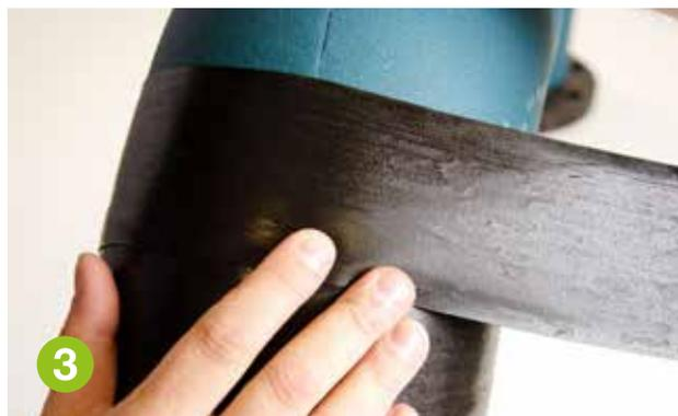
Beim Umwickeln des Rohrs eine mässige Spannung auf das selbstverschweißende Abdeckmaterial anwenden.
