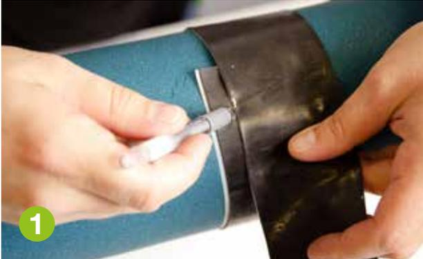
Umfang des Rohrs mit einem Streifen messen, welches mit Arma-Chek Wrap Produkt ummantelt werden soll. **Überlappung von mindestens 20 mm zum Umfang hinzufügen.**
