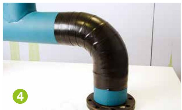
Den Wickelvorgang unter Beibehaltung der Überlappung und Spannung bis zum Erreichen des gegenüberliegenden Ende des Bogens wiederholen.
