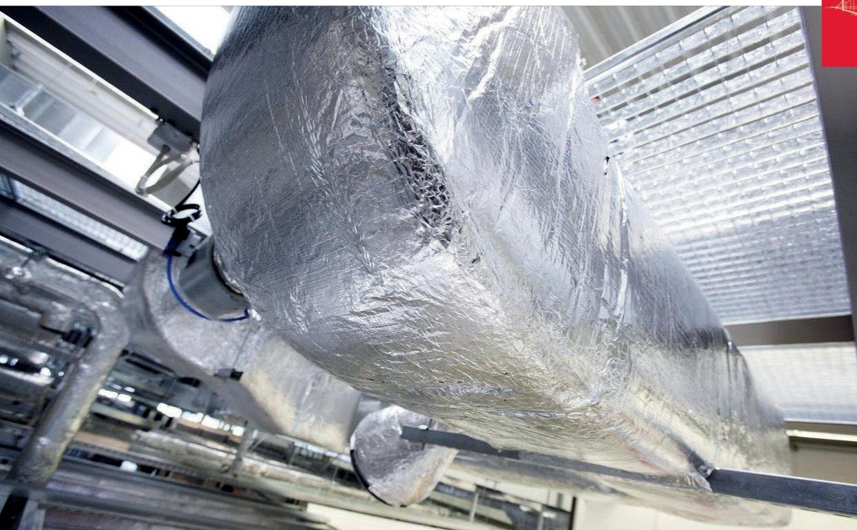
Die Steinwollematte Klimafix ist einseitig mit einer Aluminiumfolie kaschiert und auf der Wollseite mit einer selbstklebenden Beschichtung ausgerüstet. Sie kann direkt mit dem zu dämmenden Bauteil verklebt werden. Die Klebeschicht ist mit einer abziehbaren PE-Folie abgedeckt.
