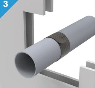
Wickeln Sie erforderliche Menge an Multiwrap-Schichten um die Durchführung.
