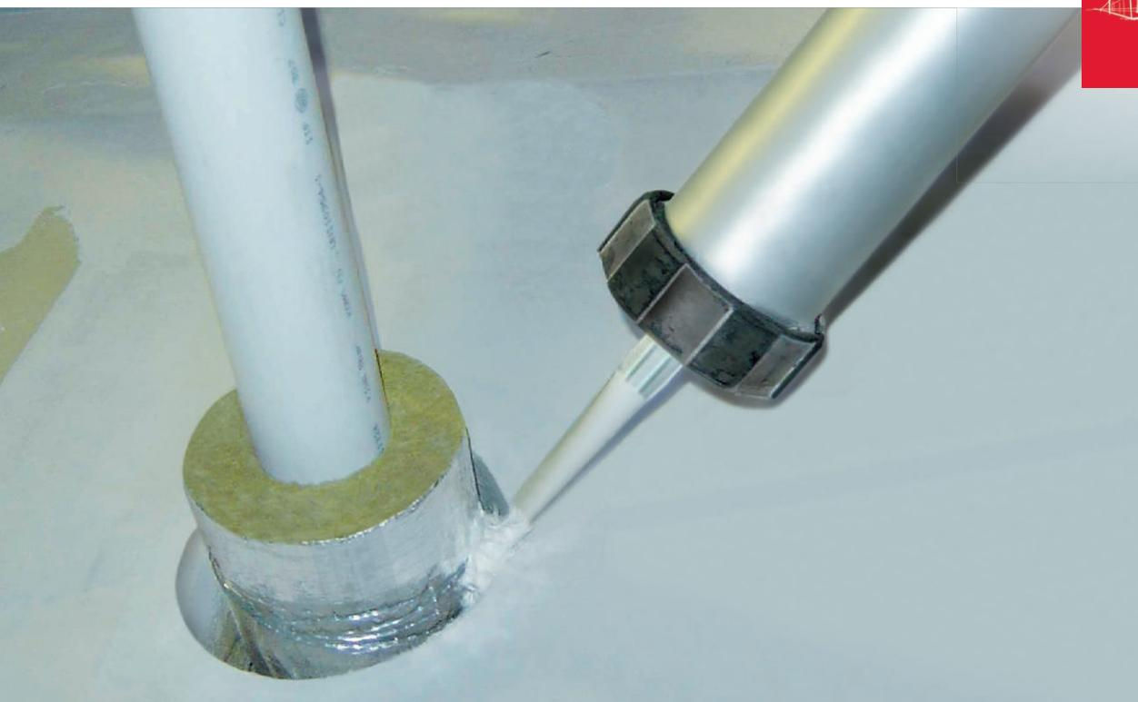
Conlit Kit ist ein lösungsmittelfreier, einkomponentiger Brandschutzkitt, der unter Hitzeeinwirkung (z. B. im Brandfall) stark aufschäumt. Hierdurch werden auftretende Fugen in Baukonstruktionen rauchdicht verschlossen. Conlit Kit kann in Verbindung mit allen Conlit Abschottungssystemen verwendet werden.
