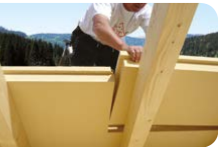
Plaatsing direct op de keper/spant
