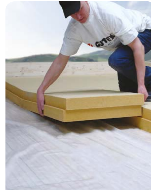
Plaatsing GUTEX Thermoflat®
