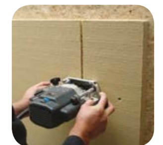
A Bevestiging GUTEX Thermostal® B Uitslijpen van leidingen C Plaatsen van gipskarton-/gipsvezelplaat
