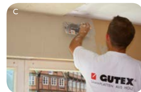
A GUTEX kleef- en spatelpleister aanbrengen B GUTEX Thermoroom® vast aandrukken C Aanbrengen van binnenpleister
