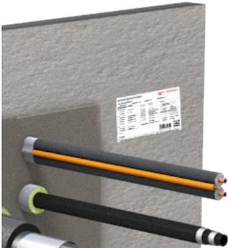
8. Mörtelreste nach Abtrocknen von Kabeln, Wänden und Böden entfernen, Flächen säubern. Abdeckfolien entfernen und ordnungsgemäß entsorgen.
