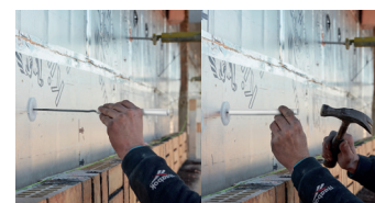
Spouwanker monteren m.b.v. aangepast inslagpijpe (L anker - L plug+10mm)
