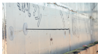
Dualfix inox aisi 304 spouwanker positioneren
