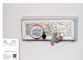
**12.** Nach der Installation wird das ausgefüllte Güteschild neben der Abschottung dauerhaft und gut sichtbar befestigt.
