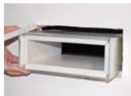
**2.** Box so in die Öffnung einsetzen, dass auf keiner Seite mehr als 8,5 cm aus der Wand stehen.
