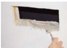
**1.** Gips- oder Mörtelbett in die Öffnung einbringen (in Trockenbauwänden mit Prüfzeugnis oder Zulassung zusätzlich eine Laibung in die Öffnung einbringen).
