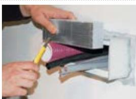
**9.** Nach der Kabelinstallation werden die EasyFoam – Stopfen einige mm größer als benötigt zugeschnitten, damit sie hinterher fest in der Öffnung sitzen.
