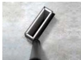
**2.** Die Kabelbox setzen Sie nun so ein, dass der Spalt umlaufend von allen Seiten dicht mit Mörtel gefüllt werden kann und dass die Kabelbox auf keiner Seite mehr als 6 cm aus der Decke steht. Zum Einfüllen des Mörtels können Sie eine Kelle oder Mörtelpumpe verwenden.
