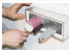
**10.** Der Stopfen wird mit der Folie nach außen in die Restöffnung eingesetzt. Reste können z.B. zur Abdichtung von Leerrohren genutzt werden.
