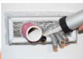
**11.** Danach werden alle Restöffnungen mit einem dauerelastischen Dichtstoff, wie z.B. Silikon, rauchdicht verschlossen.
