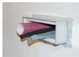
**6.** Es folgt die Kabelverlegung. Der Innenraum kann zu 100% genutzt werden. Bei großen Kabelmengen ggf. vorher schon Zwickel abdichten.
