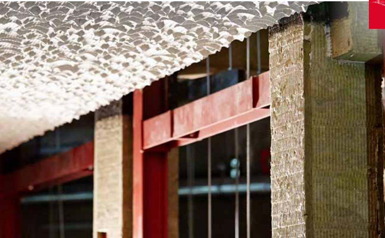
Nichtbrennbare kunstharzgebundene druckfeste Steinwolleplatten, die für die verschiedensten Anwendungen im vorbeugenden baulichen Brandschutz eingesetzt werden. Sie werden als unkaschierte Variante (Conlit Steelprotect Board) und als einseitig mit gitternetzverstärkter Aluminiumfolie kaschierte Variante (Conlit Steelprotect Board Alu), angeboten.
