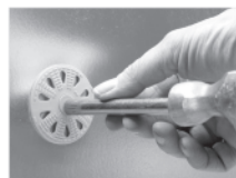
Encastrer l'ancrage à l'aide d'une douille adaptée jusqu'à la cheville.
