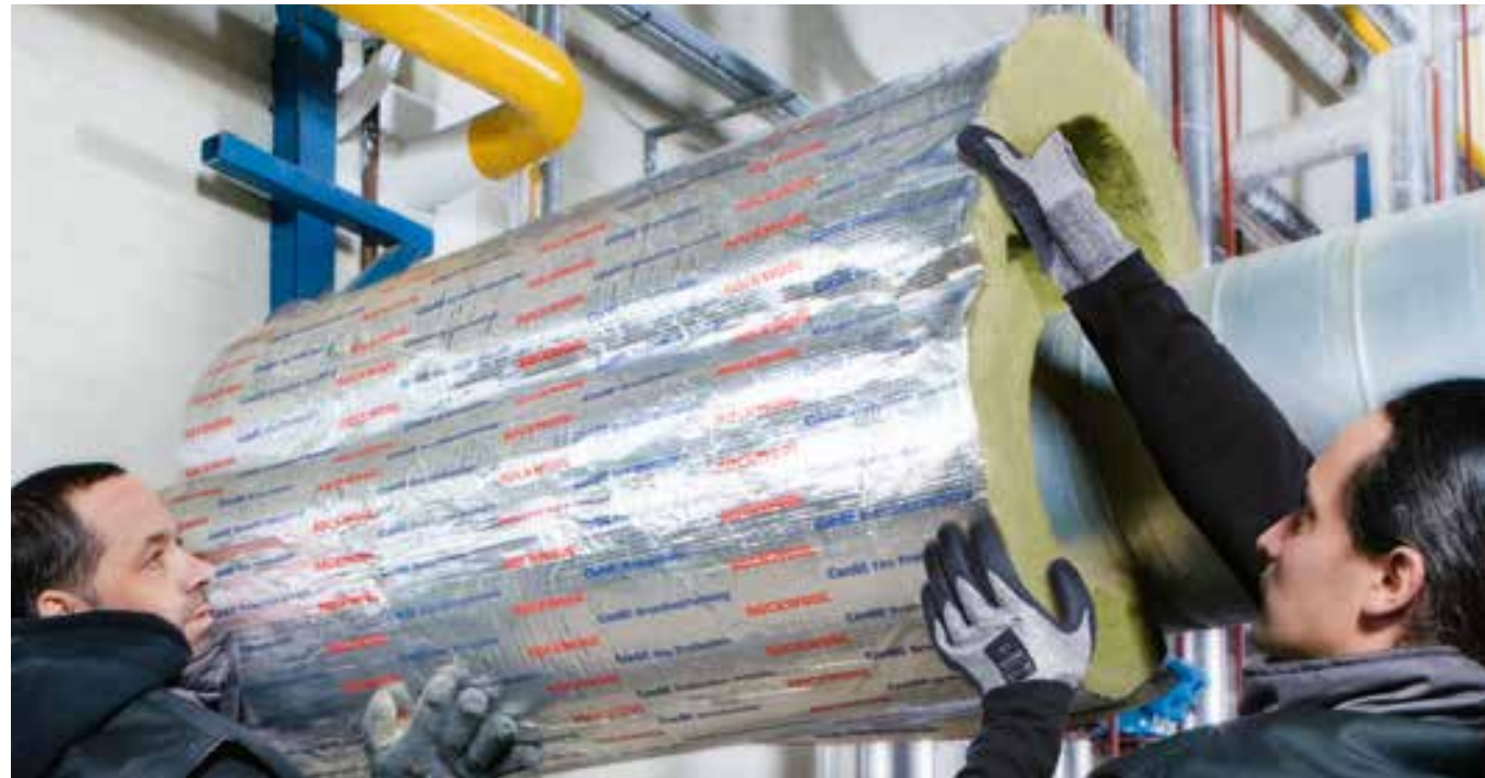
Alle Schnittstellen und Stöße sind mit Aluminiumklebeband, ROCKWOOL Alufix, zu verkleben
