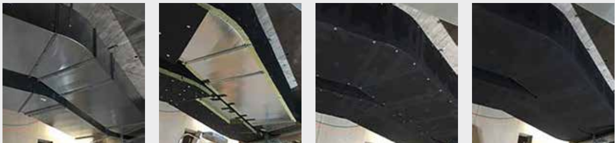
Anwendungsbeispiel PAROC Hvac Fire Slab BlackCoat
