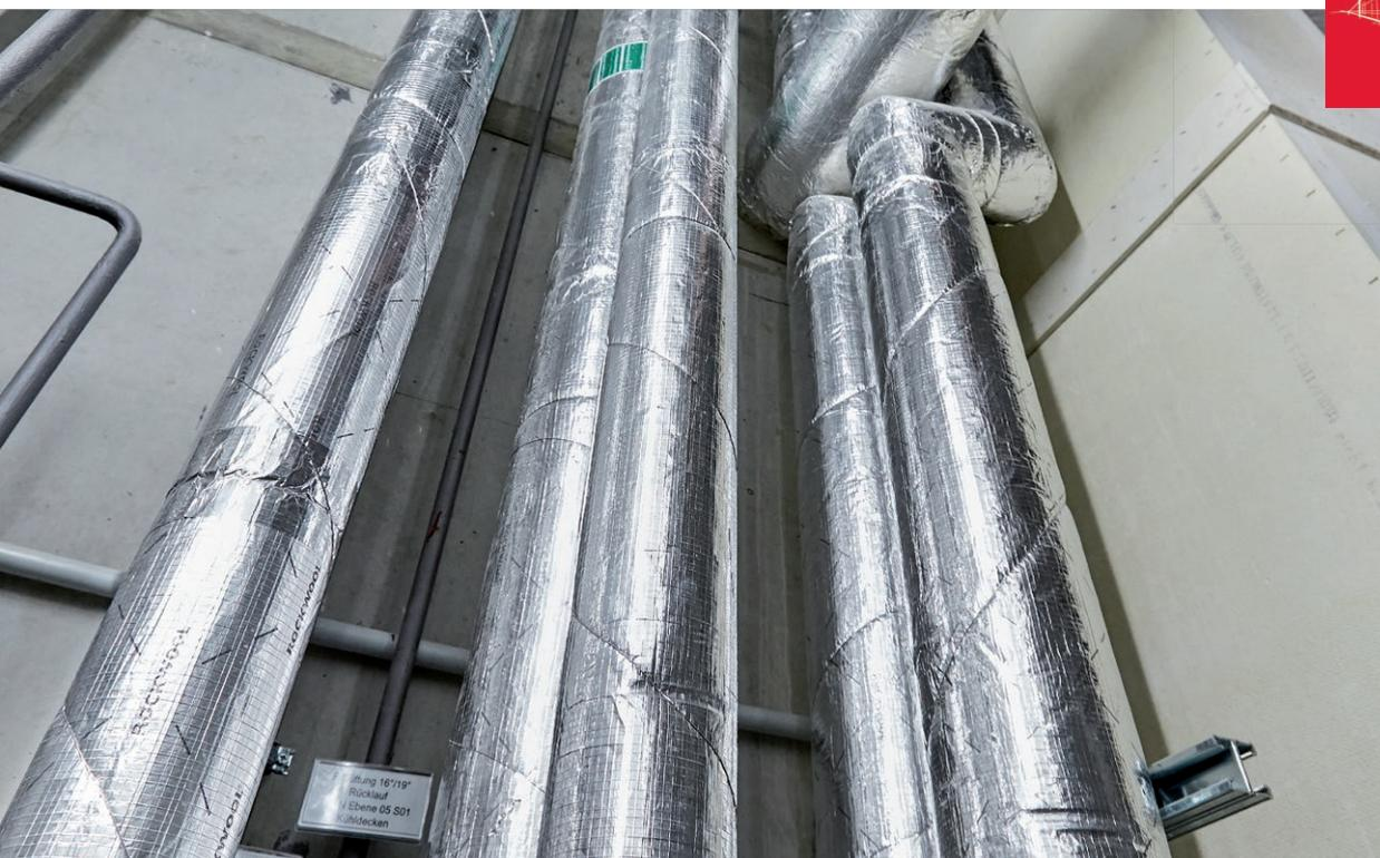
Die Rohrschale ROCKWOOL 800 wird aus konzentrisch gewickelter Steinwolle hergestellt. Sie ist mit einer gitternetzverstärkten, reißfesten Aluminium-Sandwich-Folie mit selbstklebender Überlappung kaschiert, einseitig aufgeschlitzt und zur leichteren Montage auf der Innenwandung eingesägt.
