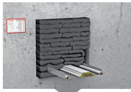
Die Brandschutzkissen sollten nach Möglichkeit stoßversetzt eingebaut werden. Abschließend muss die Abschottung mit einem Kennzeichnungsschild versehen werden.
