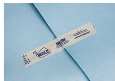
(2) Assurer le maintien des recouvrements avec le tape joint
