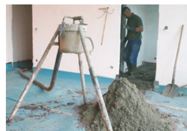
(4) Réaliser une chape de min. 5 cm d'épaisseur sur l'insulit 4+2
