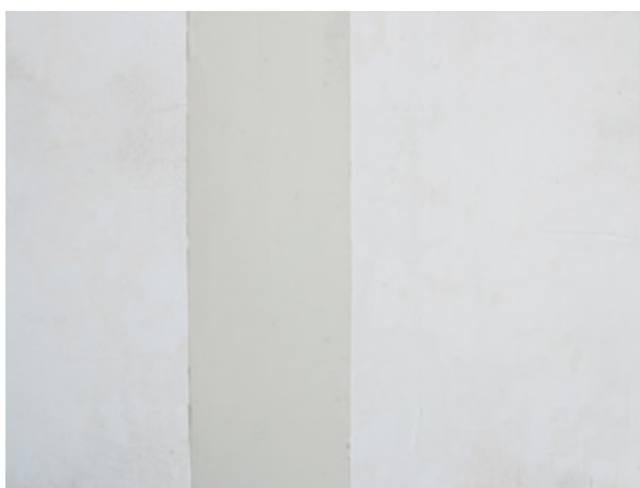
A végső hézagkialakítás simítás után
