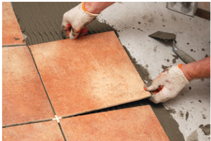
Csempézés előre elkészített Promat burkolaton
