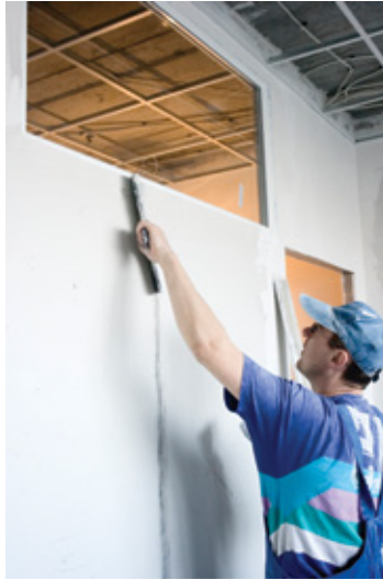
Falszerkezet lapcsatlakozásainak glettelése falon (felül balra); fal és földém kapcsolatának glettelése (felül jobbra)
