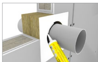
Verschließen des Ringspalts mit HENSOMASTIK® 5 KS SP
