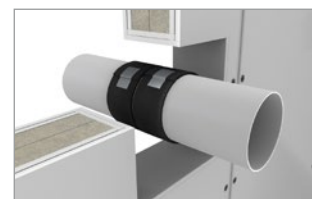
Fertige Wicklung mit Gewebeband fixieren
