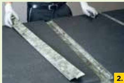
2. Verbleibende Dämmstoffstreifen entfernen
