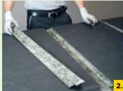
2. Verbleibende Dämmstoffstreifen entfernen
