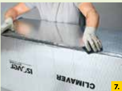
7. Klebeband anpressen – fertig ist das Kanalsegment
