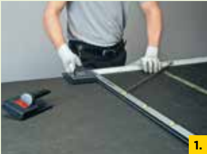
1. Stufenfalz mit CLIMAVER® Werkzeugen herstellen
