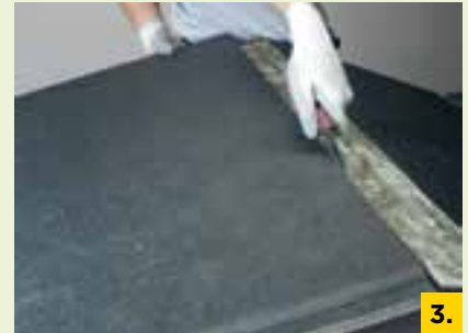
3. Wiederverwendbare Plattenreste abtrennen
