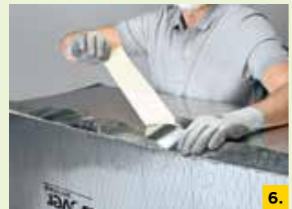
7. Stoß mit CLIMAVER® Klebeband luftdicht verkleben
