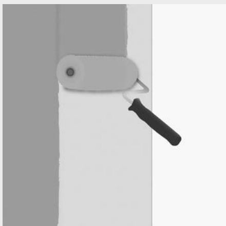
Afb. 1: fermacell Diepgrond aanbrengen op het hele oppervlak.
