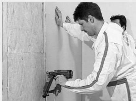
Beplating van de houten onderconstructie met behulp van nieten onder een hoek van 30 graden (rugbreedte 1 cm, draaddiameter van 1,5 cm, lengte ongeveer 3x dikte)
