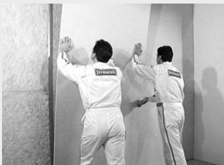
Beplating van de metalen onderconstructie
