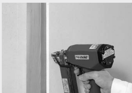
Vastnieten op een houten onderconstructie
