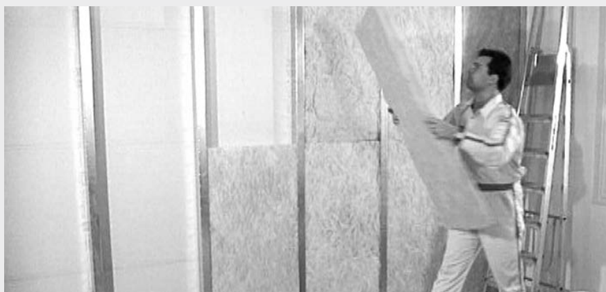
Aanbrengen van isolatieplaten
