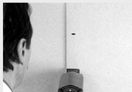
Vastnieten van fermacell op fermacell
