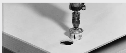
Uitboren van elektradoosparingen
