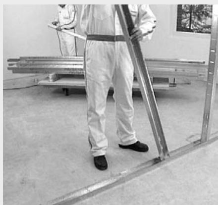
Montage van de CW-profielen
