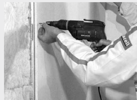
Aanzetten van de snelbouwschroefmachine
