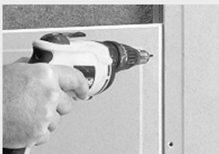
Vastschroeven op een stalen onderconstructie
