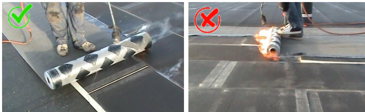
Figuur 8: Aanbrengen met brander op een PIR-isolatieplaat om goede praktijk aan te geven (links: partieel gekleefde basislaag met brander op rol; rechts: brander op isolatieplaat)
