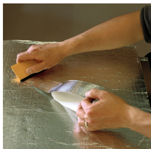
Skyddspappret tas bort samtidigt som tejpens appliceras över skadan.
