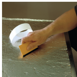
Viktigt är att tejpens trycks fast med en spatel för bästa resultat.
