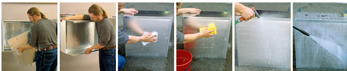
Öppning av inspektionslucka.
