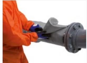
Abbildung 25: Sie können hier Band oder Klebstoff zur Hilfe nehmen, um die Position zu halten. Fahren Sie mit dem Umwickeln des Rohres fort, bis Sie die gewünschte Dämmschichtdicke erreicht haben. Schneiden Sie die Matte so, dass das Ende passend oder überlappend zum Ausgangspunkt der inneren Schicht liegt.
